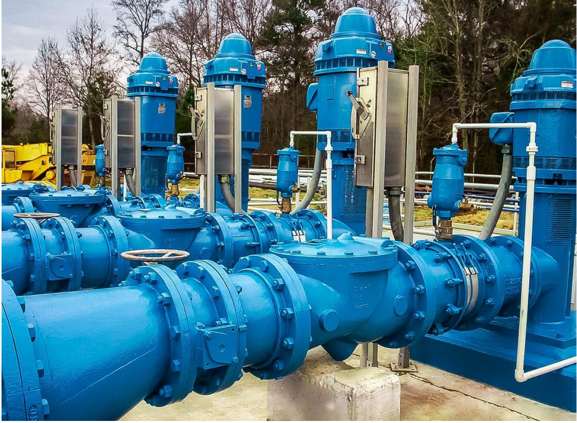
Şekil 5. Düşey olarak tasarlanmış pompaj tesisi
