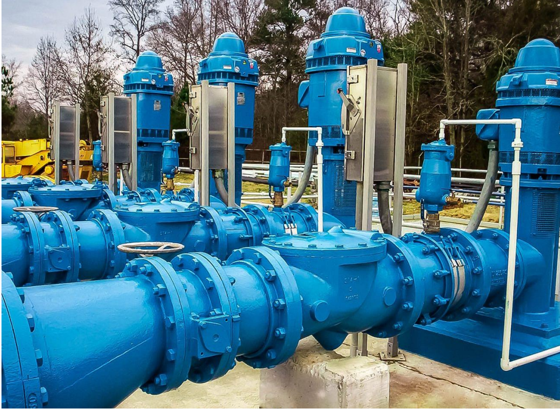
Şekil 5. Düşey olarak tasarlanmış pompaj tesisi
